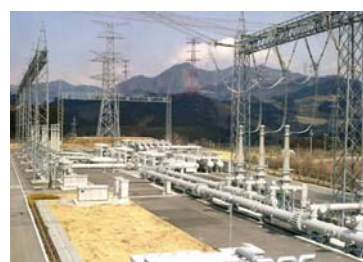
開閉装置の更なる縮小化を実現し、自然と調和した大容量 550kV 8kA GIS※3 東京電力（株）西群馬開閉所
