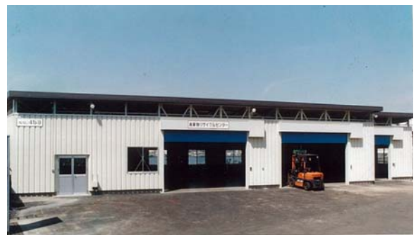
リサイクルセンターの外観
