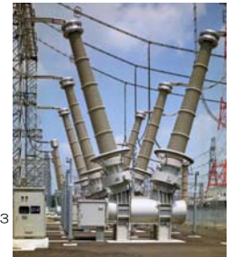
世界初の 1 点切※4 GCB※5 東京電力（株）新筑波変電所
