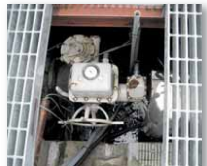
【緊急自動遮断弁】 最終放流口
