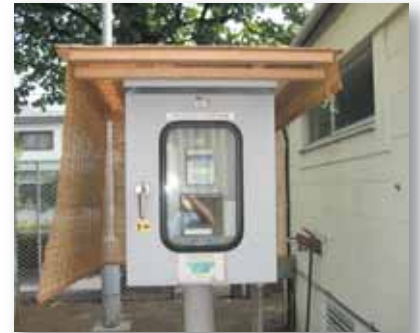
【緊急自動遮断弁】 最終放流口
