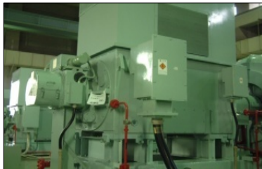
低圧電動機点検整備据付工事
