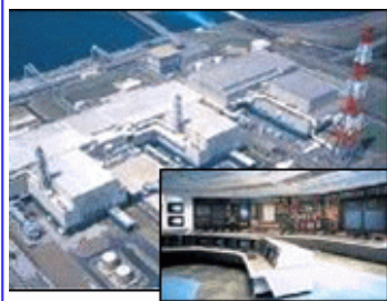
発電監視制御システム
