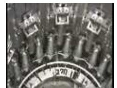
ジェットポンプの交換
