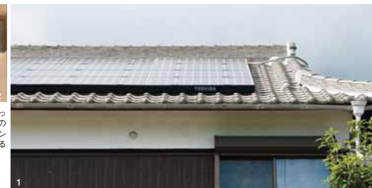
1 浪打つ和瓦にもすっきり設置できる東芝のパネル。2 パワーコンディショナは隣接する納屋に設置。
