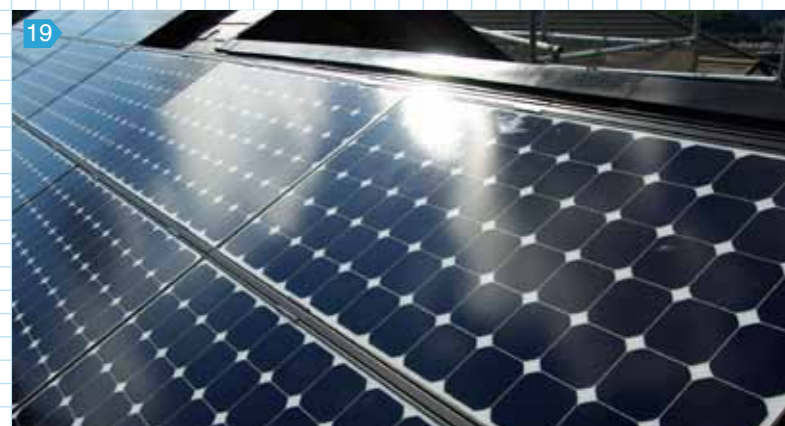
19 施工が完了した太陽光パネル
