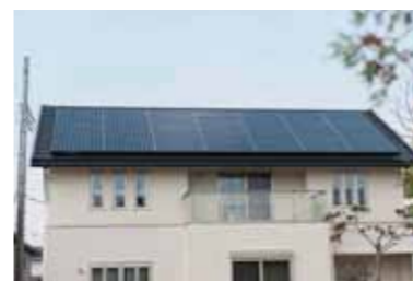
東芝の太陽光パネルは、「ソライエ」の屋根に載るコンパクトさで、7kWの発電量があると聞き、驚かれるお客さまも多いとか。
