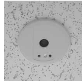
図6. 調光センサ(あかり)の外観 — 調光機能を備えたセンサ付きコントローラである。明るさ制御を行う“明るさ検知部”があり、3系統の調光制御出力を行え、取付けは天井埋込み型構造である。 Brightness detection sensor
