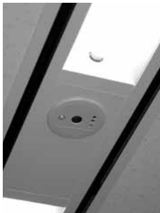
図5. 調光センサ(あかり+人感)の外観 — 調光機能を備えたセンサ付きコントローラである。明るさ制御を行う“明るさ検知部”と人の在・不在を判断する“人感検知部”があり、3系統の調光制御出力を行え、取付けは天井埋込み型構造である。 Controller with brightness detection sensor and occupation sensor
