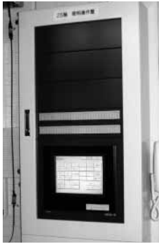
図4. 照明操作盤の外観 — 1～4フロア単位に制御を行うCPUを備えたコントローラである。リレーやセンサの制御、監視、割付け設定、スケジューラ機能を備えている。 Local lighting controller
