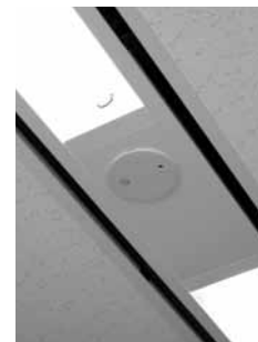
図7. 人感センサの外観 — 熱感型赤外線センサにより、人の在・不在信号で照明の点灯、減光、消灯などの制御を行える。 Occupation sensor
