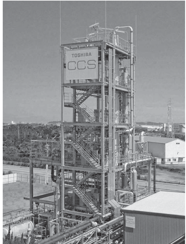
図2. パイロットプラント — 2009年9月に福岡県大牟田市の(株)シグマパワー有明三川発電所内に建設し、実証試験を開始した。
