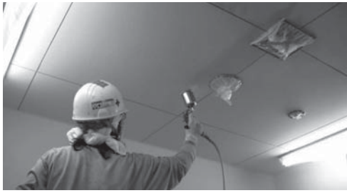
図5. 施工の様子ー スプレーガンを使って天井や壁に施工する例である。 Scene of application of RENEKAT™ to ceiling and walls
